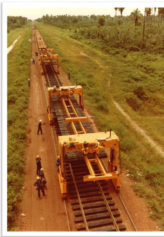
Pose de voie avec PTH 350 Geismar à Carajas Brésil, 1983
