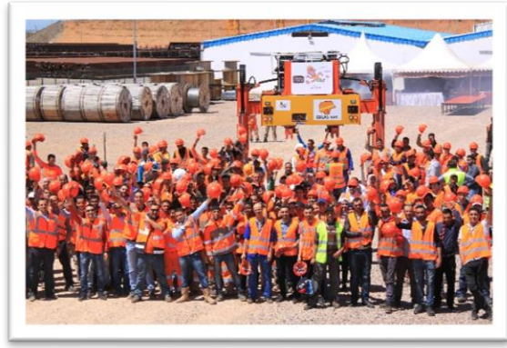
Record de pose de voie : 3564 m en 8 h (LGV Maroc)
