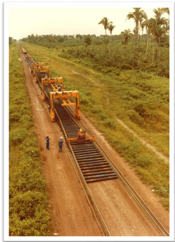
Pose de voie avec PTH 350 Geismar à Carajas Brésil, 1983
