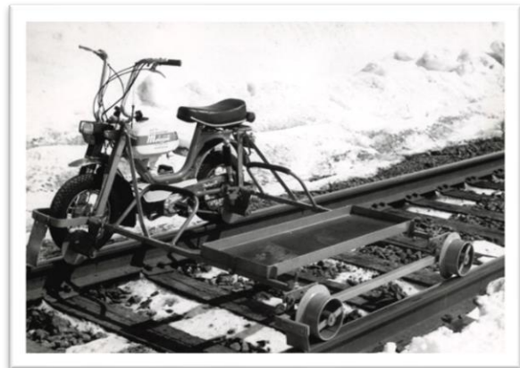
La motocyclette rail-route : simple et efficace
